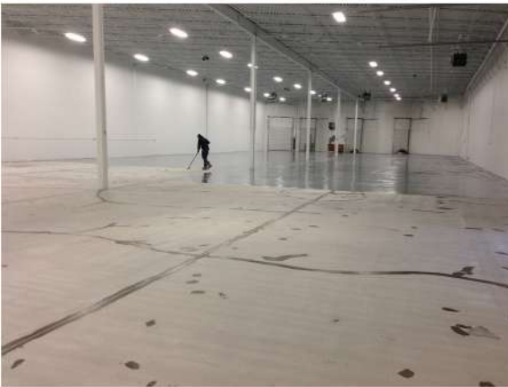
Ara Kat Epoksi Kaplama Uygulaması
