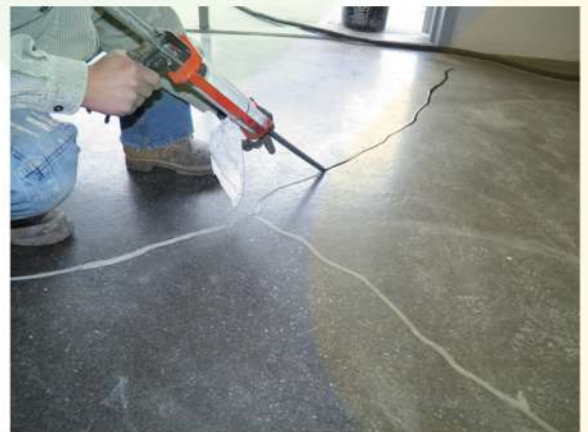
Epoksi Esaslı Derz Dolgusu İşlemi
