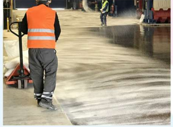
Epoksi Astar Kumlama İşlemi
