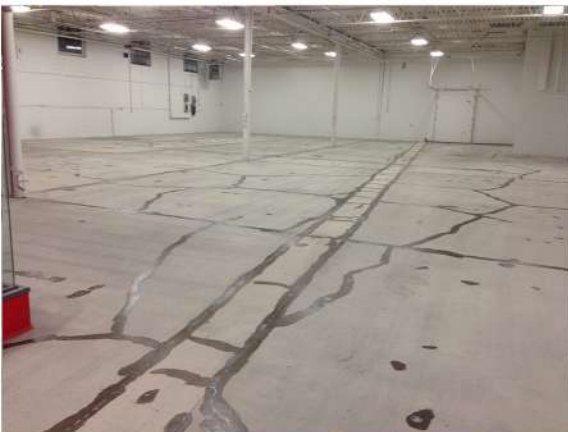
Epoksi Esaslı Derz Dolgusu İşlemi
