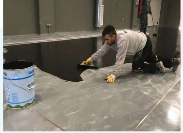
İletken Esaslı Epoksi Astar Uygulaması
