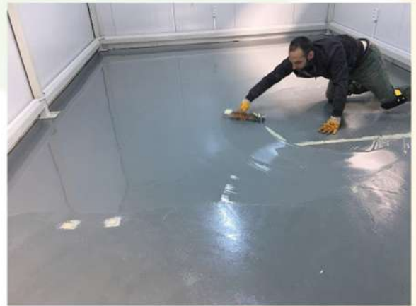
Ara Kat Epoksi Kaplama Uygulaması
