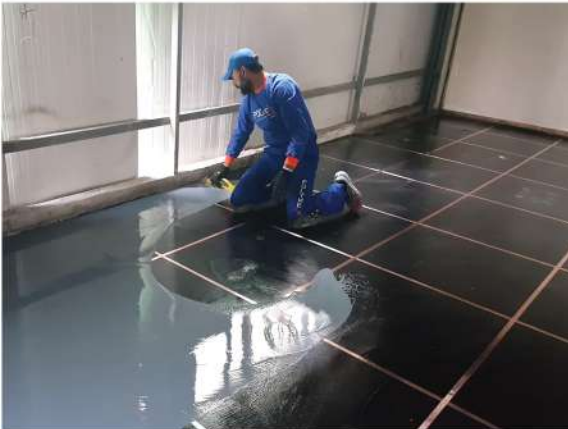
Son Kat Self-leveling Epoksi Uygulaması
