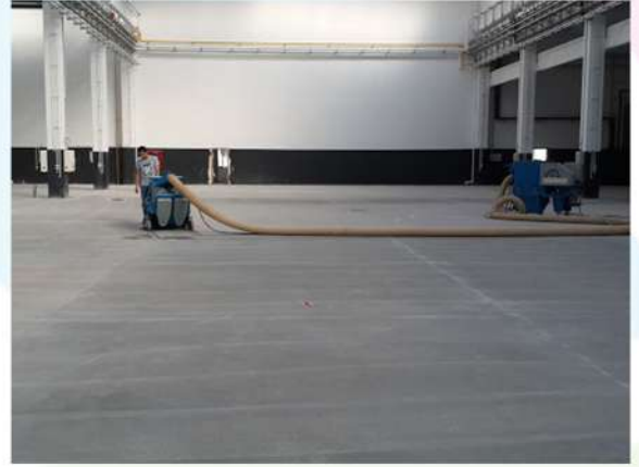
Epoksi Astar Öncesi Temizlik İşlemi
