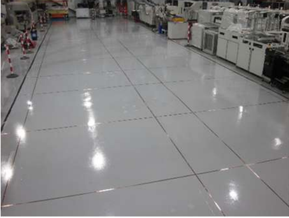
Bakır Bara Döşenmesi
