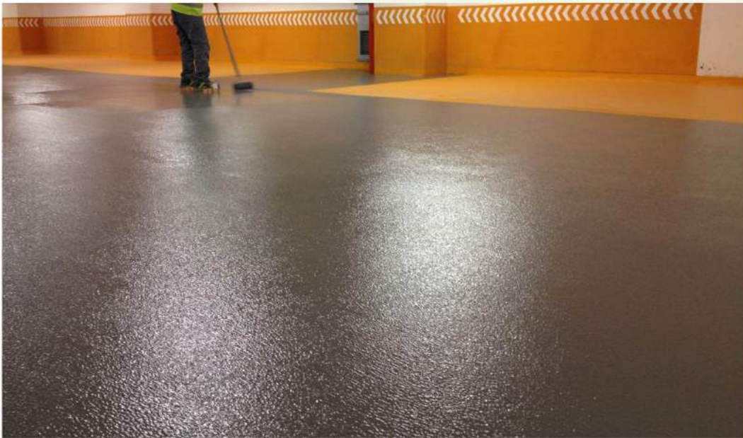
Multilayer (Portakal Yüzey) Epoksi Kaplama Son Kat
