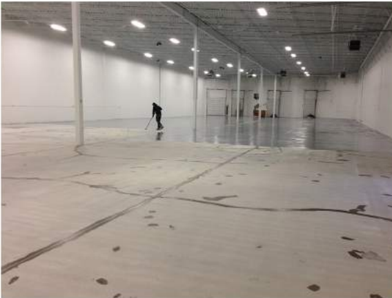
Ara Kat Epoksi Kaplama Uygulaması
