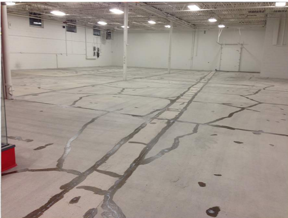
Epoksi Esaslı Derz Dolgusu İşlemi
