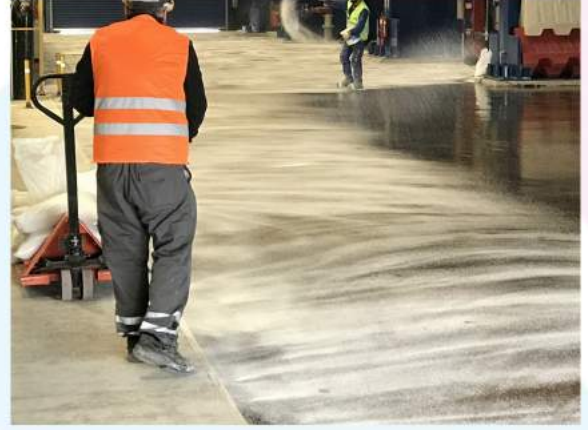
Epoksi Astar Kumlama İşlemi
