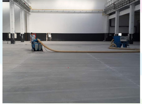
Epoksi Astar Öncesi Temizlik İşlemi
