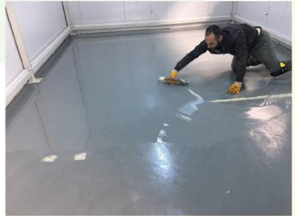
Ara Kat Epoksi Kaplama Uygulaması
