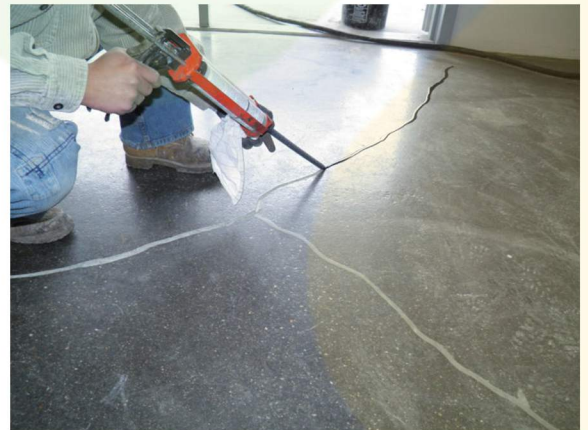
Epoksi Esaslı Derz Dolgusu İşlemi
