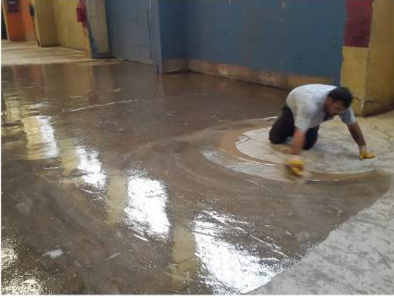
Epoksi Esaslı Astarlama İşlemi
