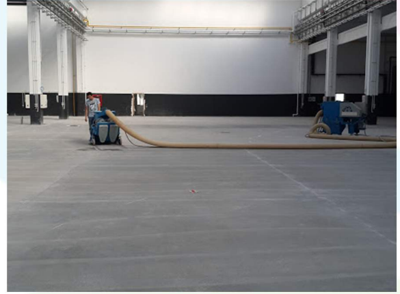
Epoksi Astar Öncesi Temizlik İşlemi
