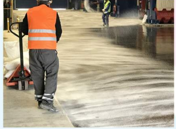
Epoksi Astar Kumlama İşlemi
