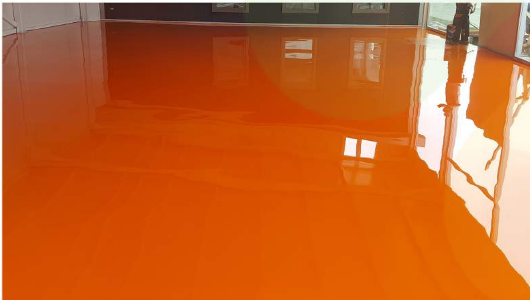
Self-levelling Epoksi Kaplama Son Kat
