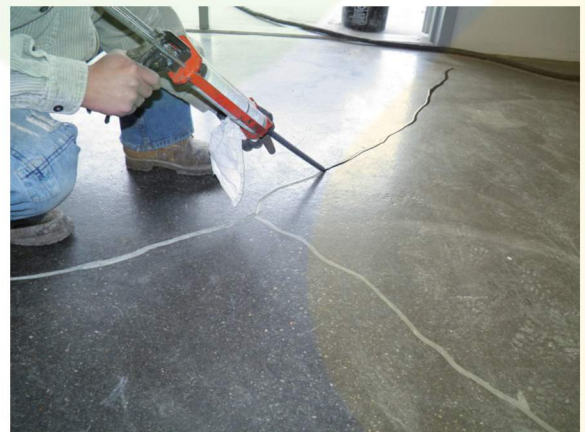
Epoksi Esaslı Derz Dolgusu İşlemi
