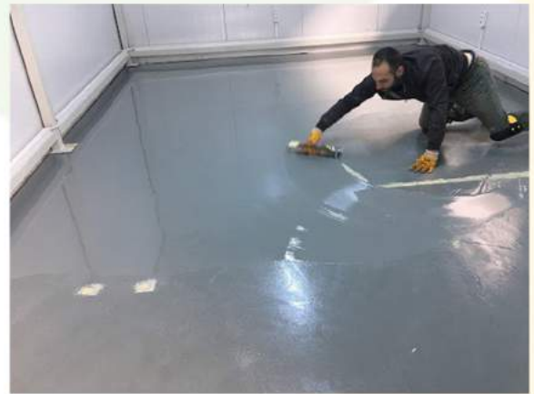
Ara Kat Epoksi Kaplama Uygulaması
