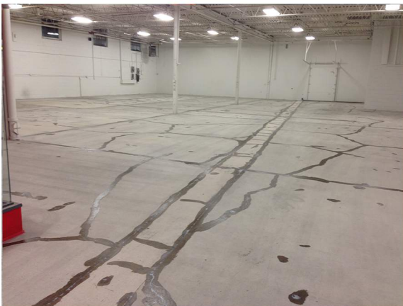
Epoksi Esaslı Derz Dolgusu İşlemi
