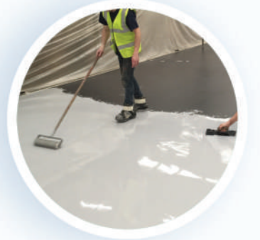
Epoksi Boya Uygulanması
