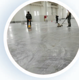
Zemin Silimi ve Temizlenmesi
