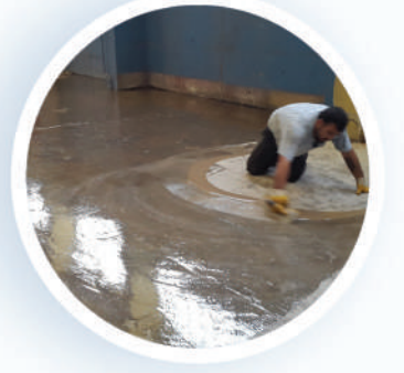
Epoksi Esaslı Astar Uygulanması
